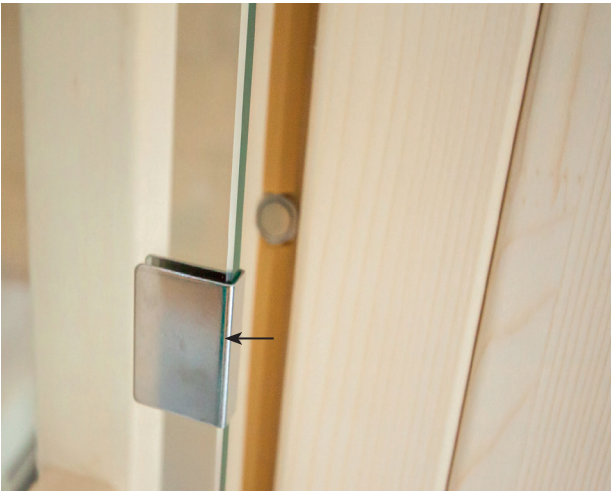
Abb. 35: Montage Überschub-Blech
