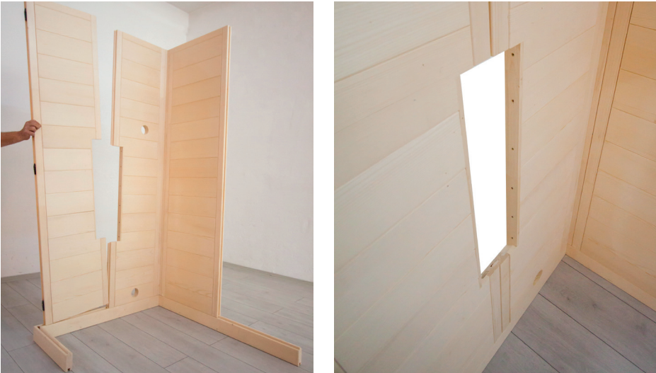
Abb. 6: Wandelement mit Ausschnitt einsetzen
