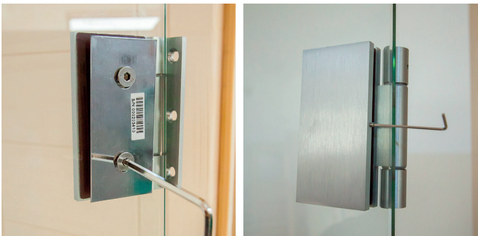
Abb. 32: Montage Türbeschläge 2
