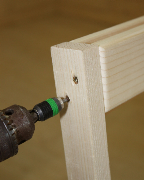
Transportleiste vom Türstock entfernen
